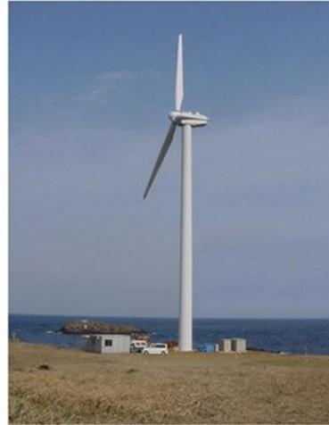
三菱1000KW水平軸風車
